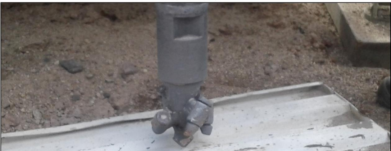
Una vez alcanzado el estrato no perforable con cola de pez, se sustituye por martillo de fondo DTH (Down The Hole) de 4” de diámetro y se emplea rotopercusión para la roca fractura y/o sana.
