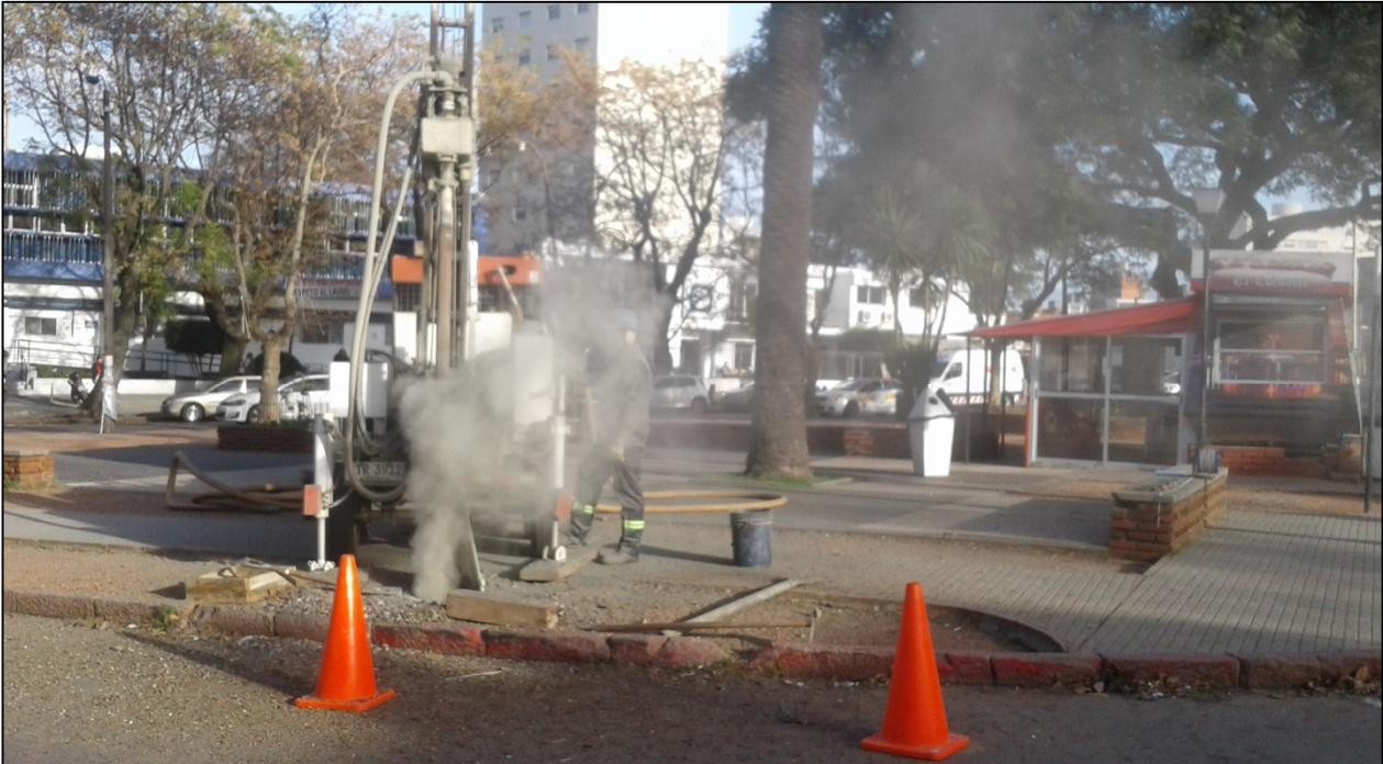
Las herramientas seleccionadas para la exploración responden al objetivo de la misma. En una primera instancia se empleó, una broca tipo cola de pez (o “manito”) que permite remover suelos duros, y rocas alteradas mediante rotación y flujo interno de aire comprimido. Esta herramienta no permite remover rocas fracturadas o sanas, por lo que se emplea para determinar espesor del estrato alterado de roca que no es penetrable mediante SPT.
