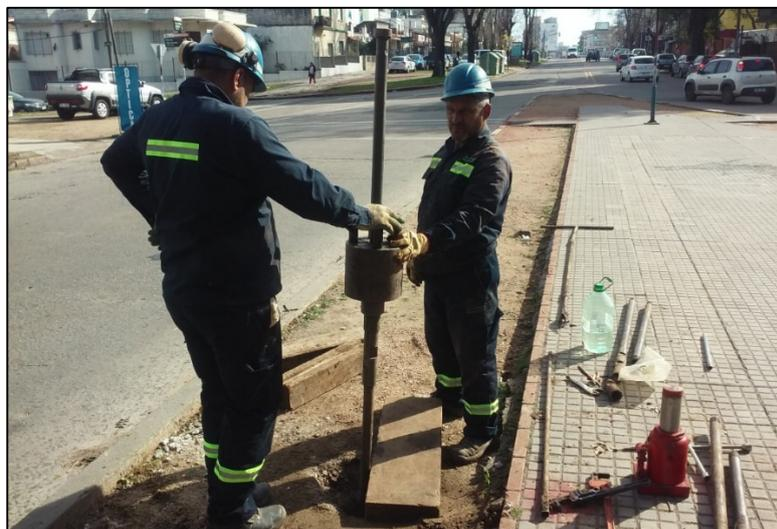
Dicha información se complementó mediante perforaciones en los sondeos 3 y 5 (seleccionados por caracterizar los dos tipos de macizos rocosos identificados), empleando una perforadora accionada por compresor de aire a los efectos de superar las profundidades de rechazo del ensayo de penetración estándar, y diferenciar los niveles alterados, fracturados y frescos del macizo rocoso y así poder inferir su excavabilidad, así como instalar los freáticos para establecer la presencia o no de agua.
